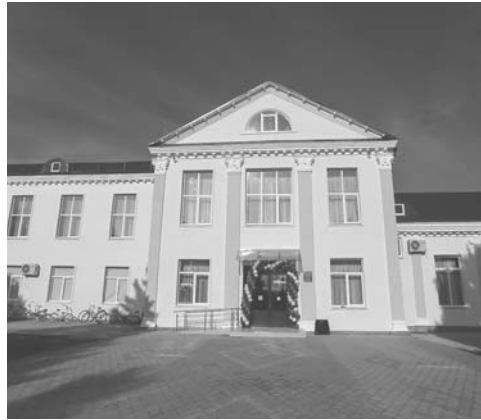
Дом культуры станции Новоджерелиевской после ремонта
